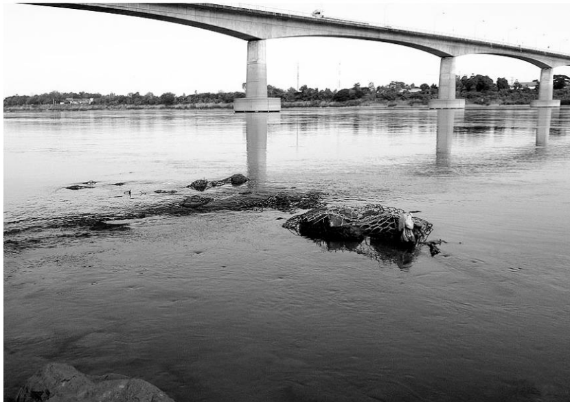
รอบ50ปี - น้ำโขงที่ไหลผ่าน จ.หนองคาย ลดต่ำต่อเนื่องเหลือเพียง 1.12 เมตรเท่านั้น ทำให้เสาเข็มใต้เสาดอม่่อสะพานมิตรภาพไทย-ลาวแห่งที่ 1 และทุ่นตาข่ายบรรจุหินใต้เขื่อนป้องกันตลิ่งแม่น้ำโขงโผล่ให้เห็นอีกครั้ง เป็นระดับต่ำสุดในรอบ 50 ปี เมื่อวันที่ 5 พฤศจิกายน
