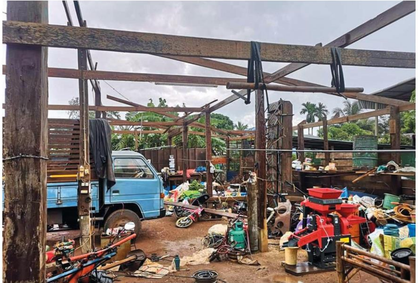
🏠 หลังคาเปิง - บ้านพักและโรงเรือนในพื้นที่ ต.กุดโบสถ์ อ.เสิงสาง จ.นครราชสีมา ถูกพายุฝนถล่มลมหอบหลังคาปลิวเสียหายกว่า 40 หลังคาเรือน ชาวบ้านระบุเป็นพายุฝนที่พัดถล่มรุนแรงหนักในรอบ 10 กว่าปี เมื่อวันที่ 4 ก.ย.
