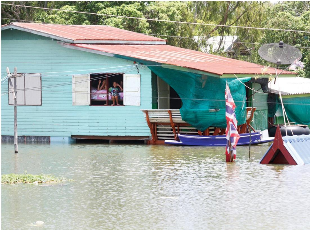
🏠 จมนับเดือน - แม่น้ำน้อยล้นตลิ่งในพื้นที่ อ.เสนา จ.พระนครศรีอยุธยา ยังท่วมสูงกว่า 2 เมตร ปริมาณน้ำมา นานนับเดือน แม้เขื่อนเจ้าพระยาเริ่มลดการระบายน้ำลงท้ายเขื่อน แต่ระดับน้ำในพื้นที่ยังไม่ลดลง เมื่อวันที่ 4 ก.ย.
